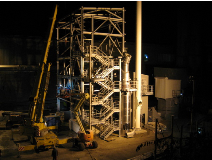
Erste industrielle Anlage in Bau
